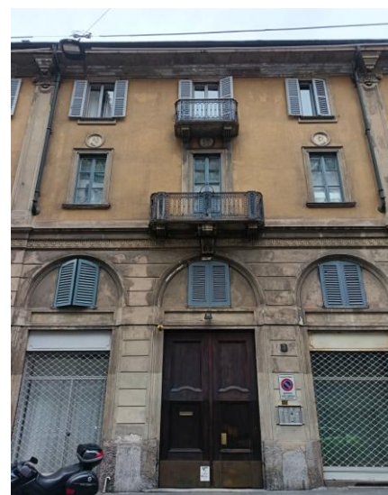
Facciata della casa in via Rossini, 3
